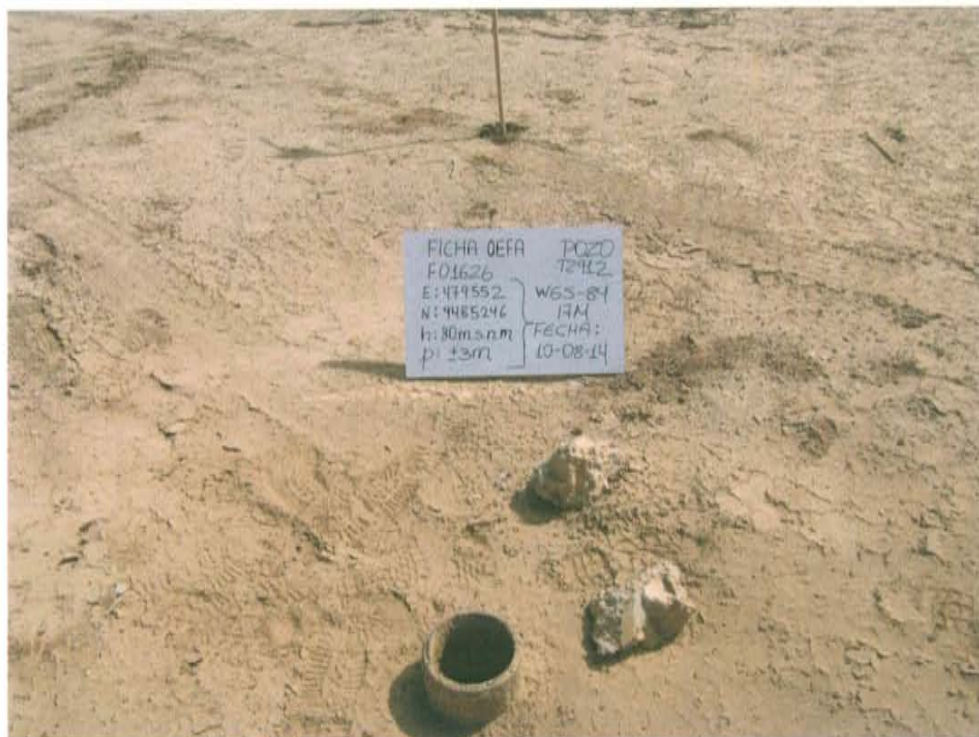
Fotografía N° 1. El Pozo T2912 presenta casing cortado y corroído de aproximadamente 7,5 pulgadas que sobresale 0,1m sobre la superficie del suelo.
