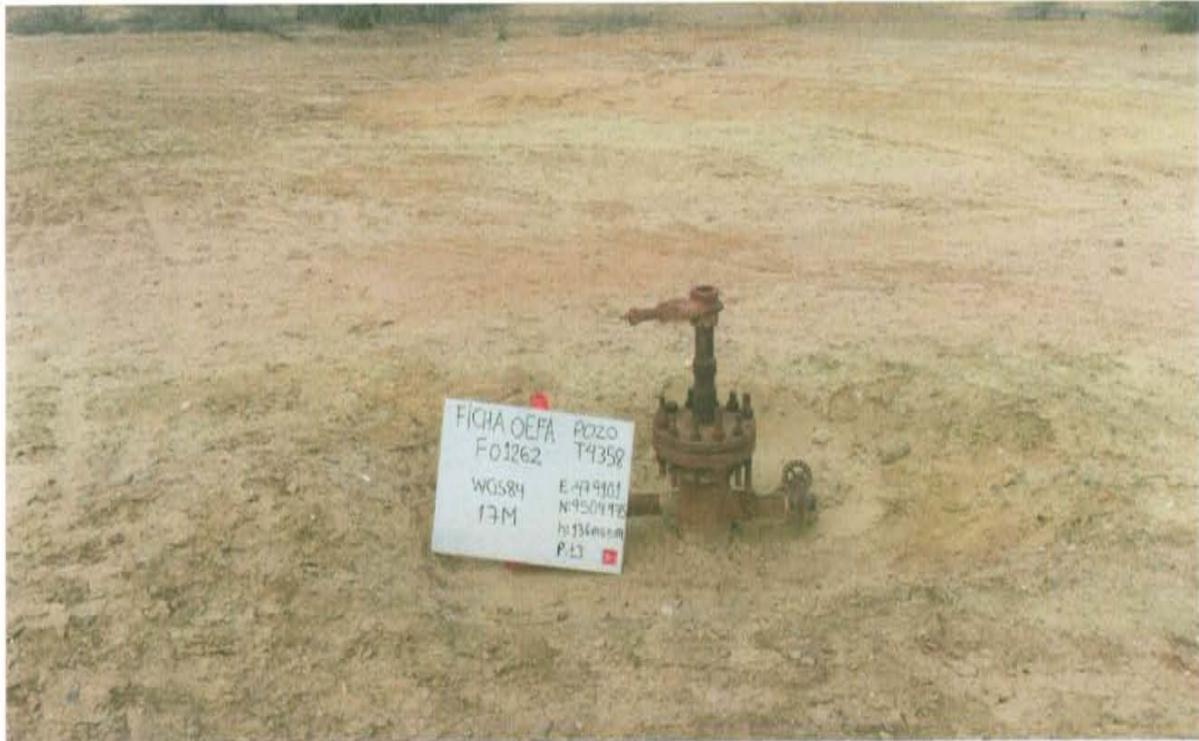
Fotografía N° 1. Pozo con código Ficha OEFA F01262 y con código PERUPETRO T4358, se observa el casing con dos tuberías laterales con un cabezal compuesto por una brida reductora y una tubería de reducción, asimismo, presenta dos válvulas (concéntrica y lateral) con signos de corrosión que no asegura su hermetismo.
