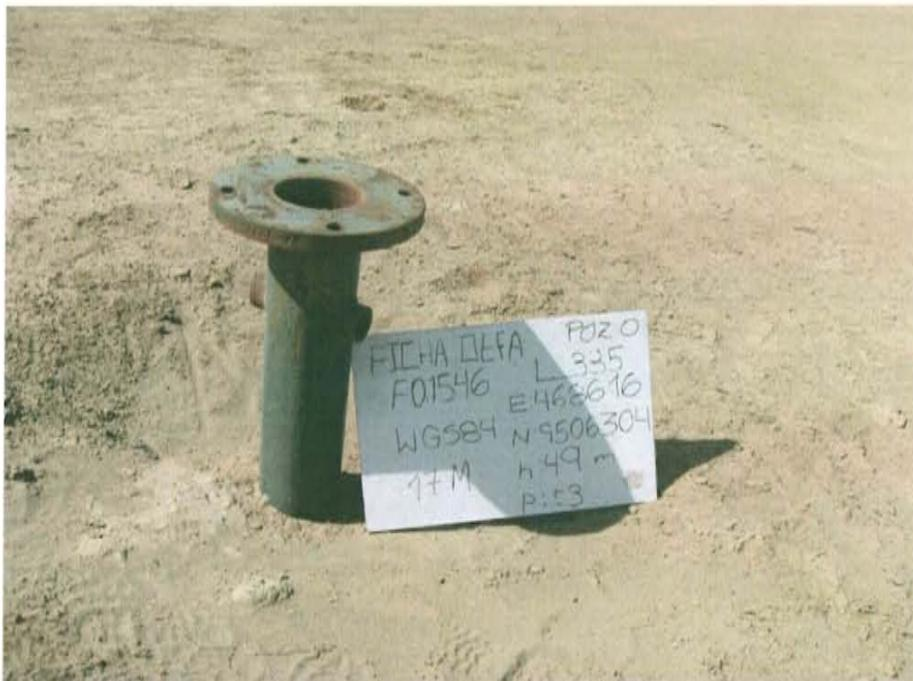
Fotografía N° 2. Se observa Pozo que presenta casing, sin elemento de cierre en superficie (válvulas, llaves entre otros) que garanticen un cierre hermético del pozo.
