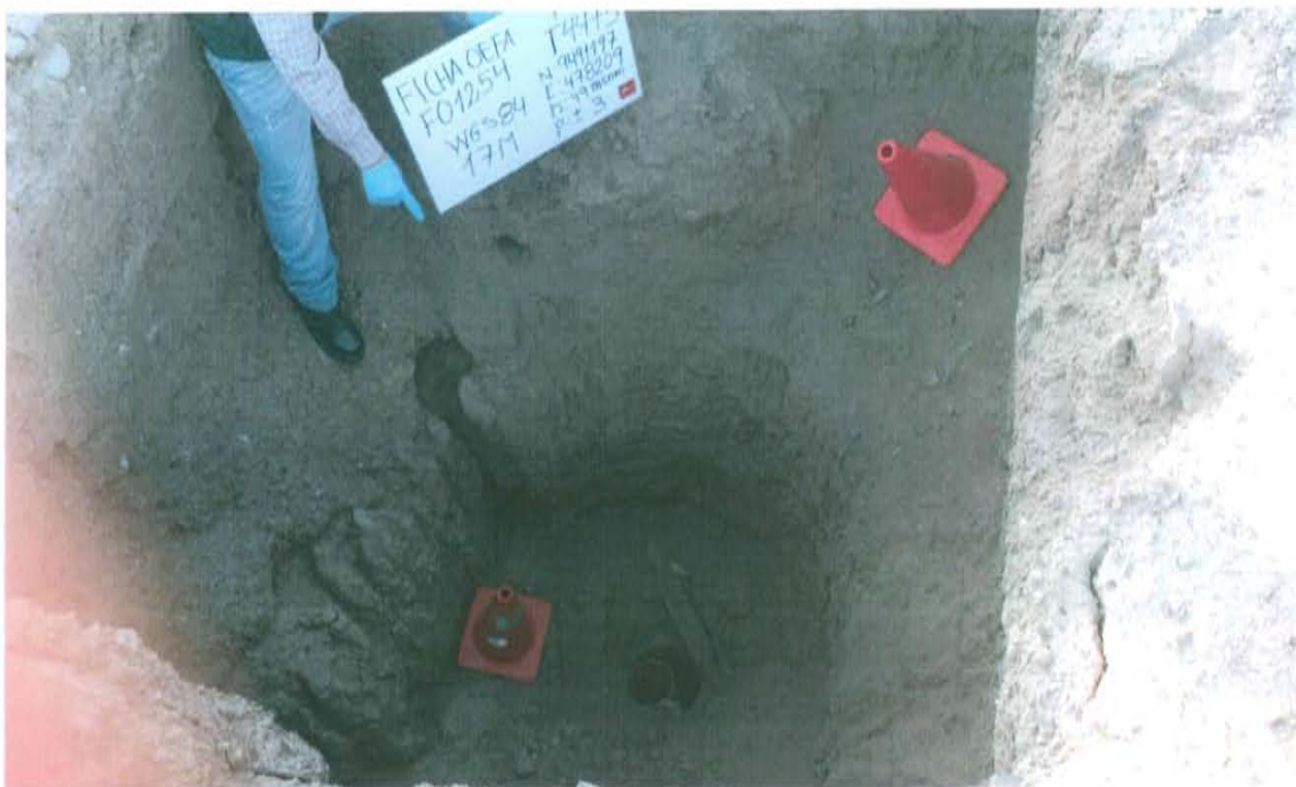
Fotografía N° 1. Pozo con código Ficha OEFA F01254 y con código PERUPETRO T4475, se observa el casing a nivel de la superficie del suelo del que sobresale una tubería expuesta a 0,15 m sobre la superficie del suelo, no presenta cabezal ni válvulas de cierre por lo que se encuentra expuesto al ambiente.
