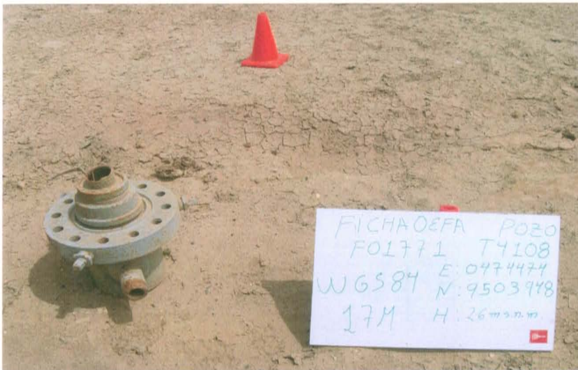
Fotografía N° 01.- Pozo con código PERUPETRO T4108 y con código Ficha OEFA F01771, se observa el casing con una tubería lateral unida con una brida reductora a una tubería que se encuentra abierta y sin cabezal o válvula que asegure su hermetismo por lo que se encuentra expuesto al ambiente.
