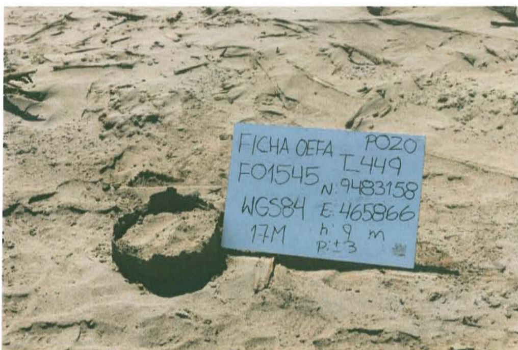
Fotografía N° 2. Se observa casing obstruido con arena y abierto al ambiente.
