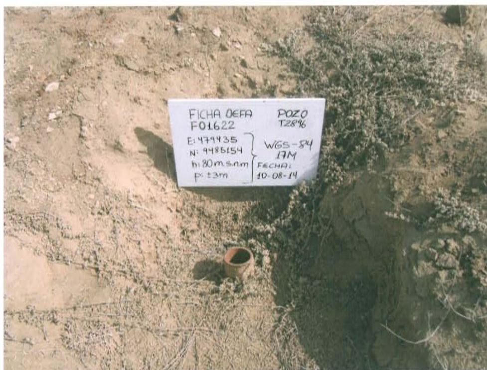
Fotografía N° 1. El Pozo T2896 presenta casing cortado y corroído sin cabezal ni válvulas que aseguren su hermetismo.
