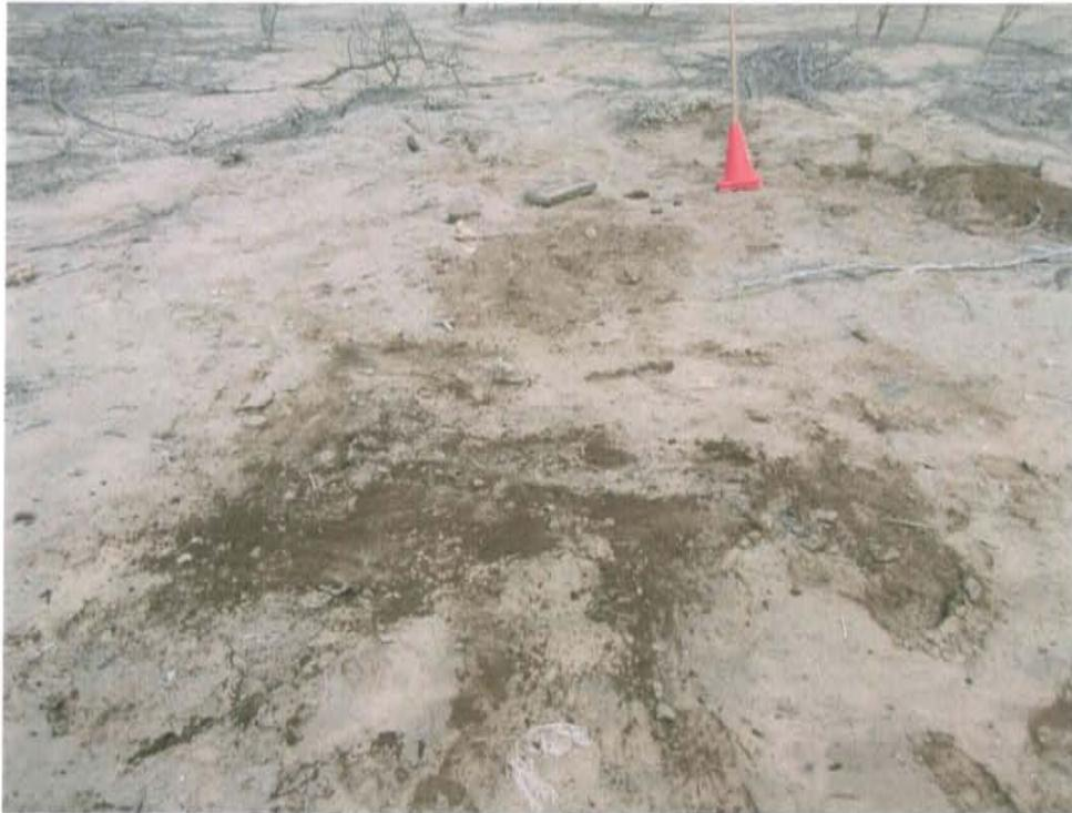
Fotografía N° 3. Adyacente al Pozo T2996 se observa suelo superficialmente impregnado con hidrocarburos.
