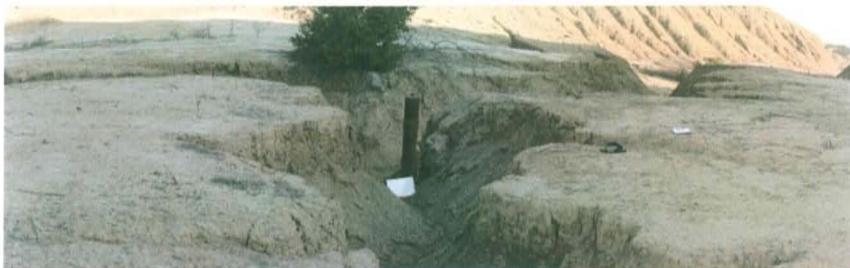
Fotografía N° 1. Vista panorámica del Pozo inactivo, ubicado en el cauce de una quebrada seca.
