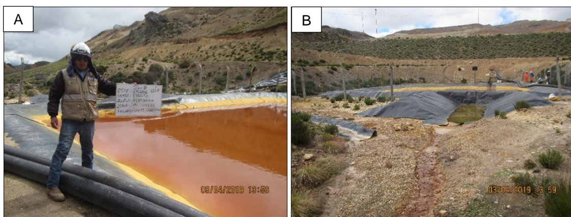
Figura 5.8. Poza de subdrenaje N.º 3 (SW-10) (A), flujo de agua en dirección a la quebrada Luchusani - SW-10 (B) y comportamiento de los parámetros de campo y sulfatos (C)
