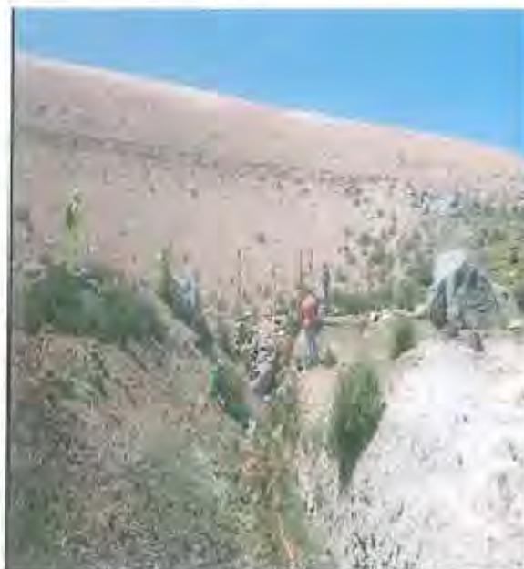
**Observaciones:** Afloramiento de agua proveniente de la parte inferior del dique del deposito de relaves Explorador N° 1 (Subdrenaje)
