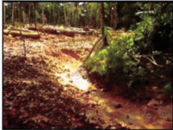
Fotografía 2.- Canal construido para el drenaje y desvío de agua de escorrentía.
