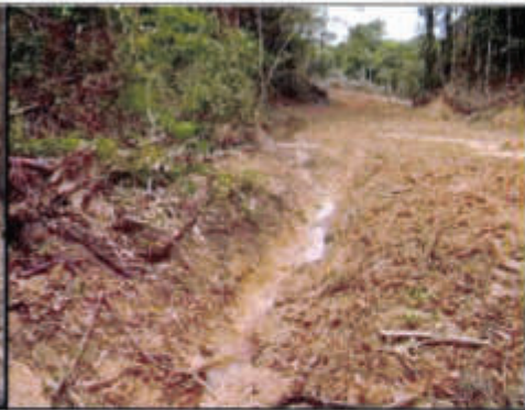
Foto 14: Canal construido de drenado principal que circula por el sitio remediado.
