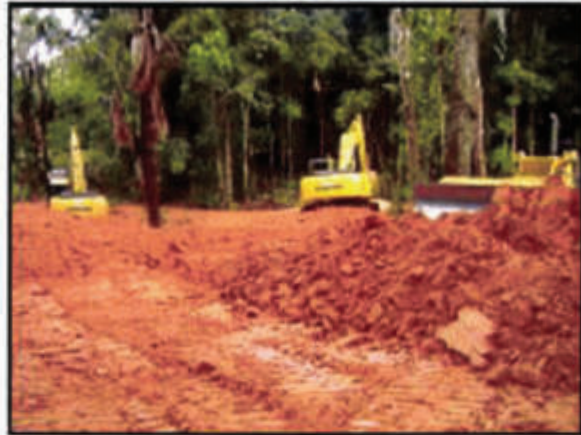
Fotografía 1.- Vista de la excavación de suelo contaminado.
