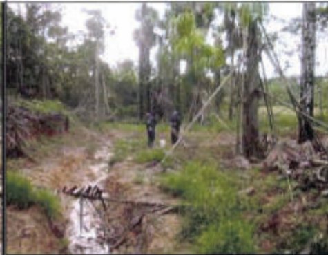
Foto 10: Realizando calicatas distribuidas en todo el área para la colecta de muestra M-02 en el sitio remediado. Nótese además de la construcción de un canal secundario de drenaje de agua de lluvia.
