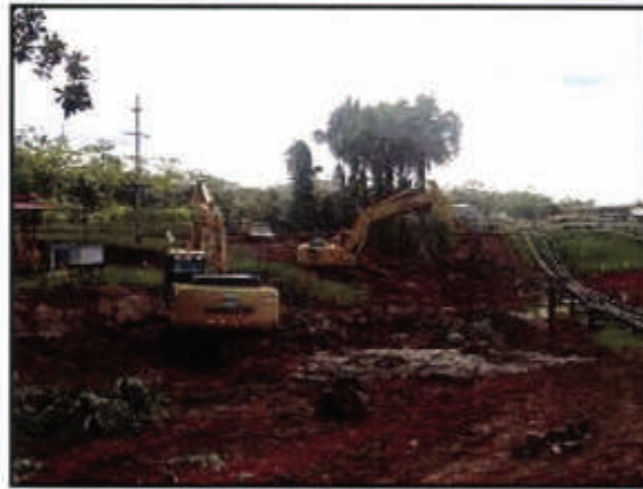
Fotografía 1.- Vista de la excavación de material contaminado previos a la remediación.
