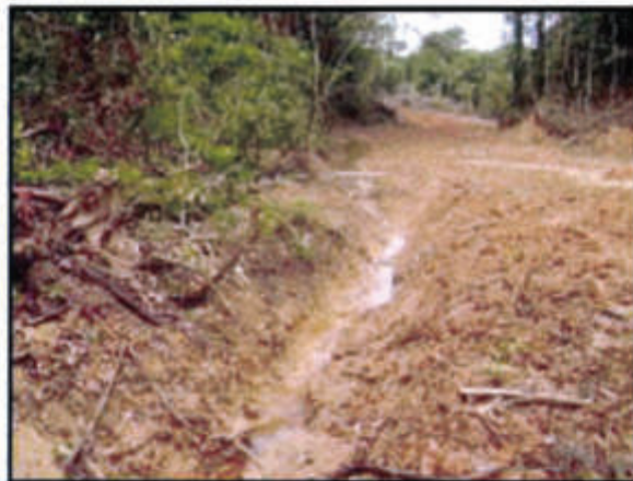
Fotografía 2.- Canal construido para el drenaje y desvío de agua de escorrentía.
