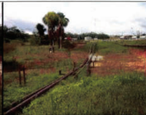
Foto 02: Vista general parcial de la parte Norte del área remediada fotografía tomada muy cerca al acceso y al de la línea de producción.
