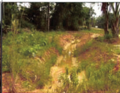
Foto 12: Canal de drenado pluvial principal, construido en el sitio remediado.
