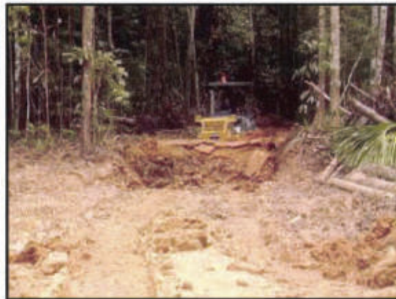
Fotografía 2.- Acarreando material de préstamo (07-2006).
