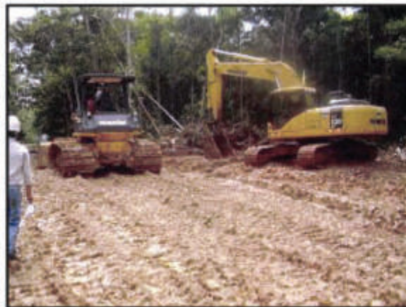
Fotografía 3.- Excavación y mezcla de suelos (07-2006).
