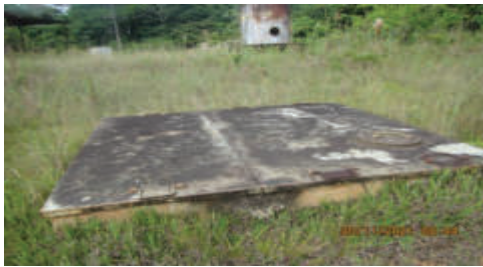
Vista del tanque sumidero de plataforma D
