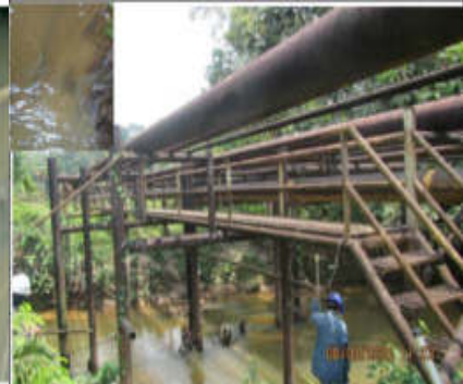
Vista de ducto de gas para quema. Cruza la quebrada Pucacuro.
