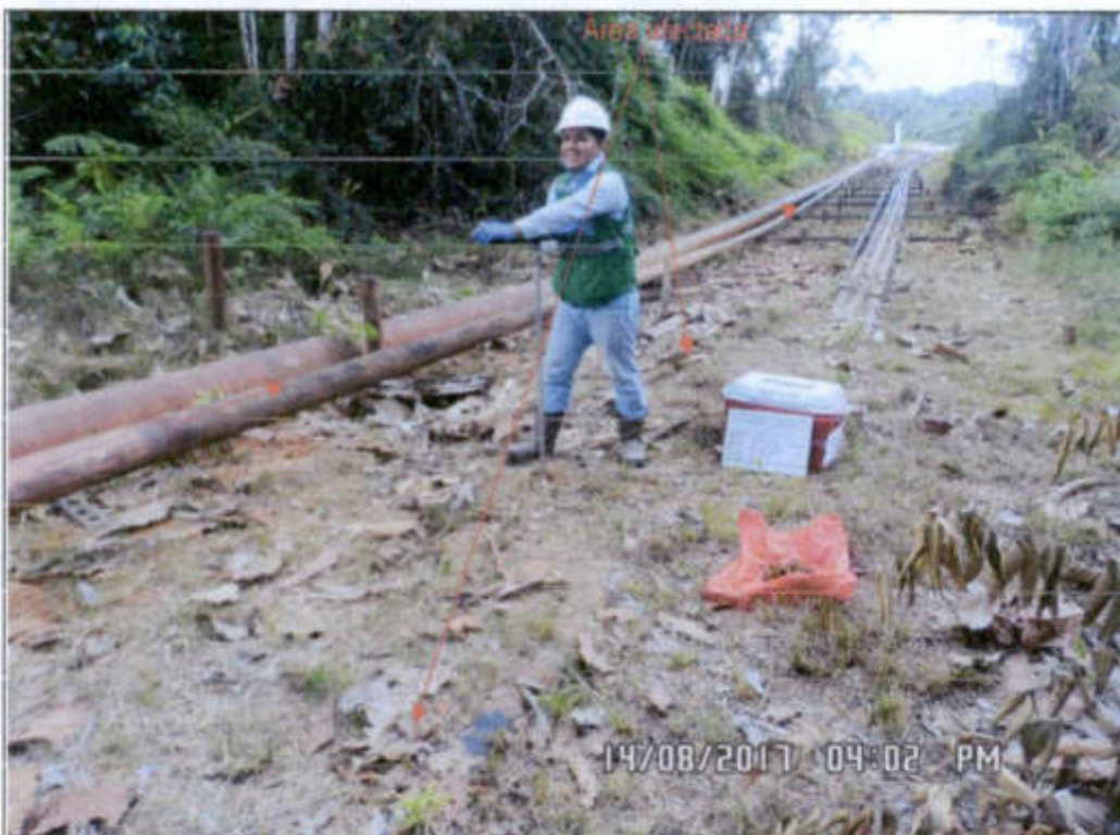
Fotografía N° 8.02: Muestra el Área posiblemente afectada por el derrame. Terreno adyacente al punto de fuga, se circunscribe al área ocupada por el rack de tuberías que transitan hacia la Batería Dorissa. (Coordenadas UTM WGS84: 367002 E, 9696602 N).
