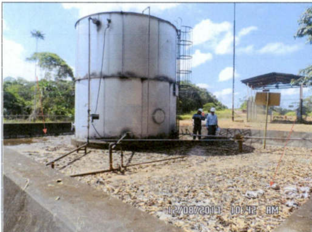
Fotografía N° 1.02: Muestra el área estancia del tanque 500, conformado con piso y diques de concreto, con un sumidero y válvula de control y descarga de agua pluvial de 6", punto de vertimiento terreno adyacente en la esquina noreste. (Coordenadas UTM WGS84: 332988 E, 9703870 N).
