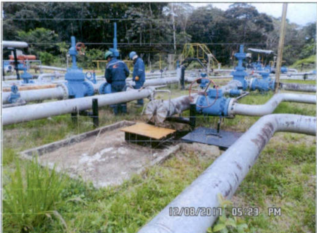
Fotografía N° 5.02: Muestra el Área de trampas lanzadoras/receptoras de raspabombos, en la cual se encuentran las trampas de raspabombos de los oleoductos que convergen en la Capahuari Sur, el drenaje interno está integrado hasta un buzón de reunión y de allí al tanque colector de 100 Bbls, ubicado al este de la plataforma. (Coordenadas UTM WGS84: 341085 E, 9689667 N).
