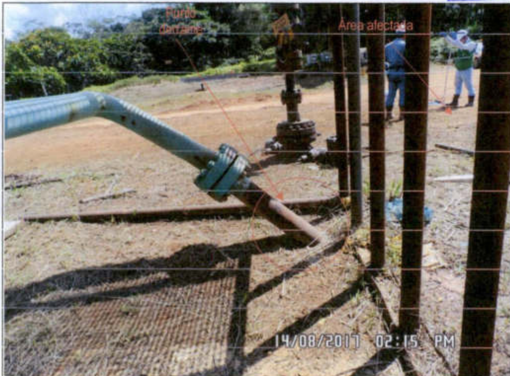
Fotografía N° 7.02: Muestra el área Línea de inyección de 6" punto de falla. Recorre desde las bombas hasta el pozo, 50 m enterrado y 7 m antes del cabezal del pozo es aéreo. (Coordenadas UTM WGS84: 366074 E, 9697287 N).
