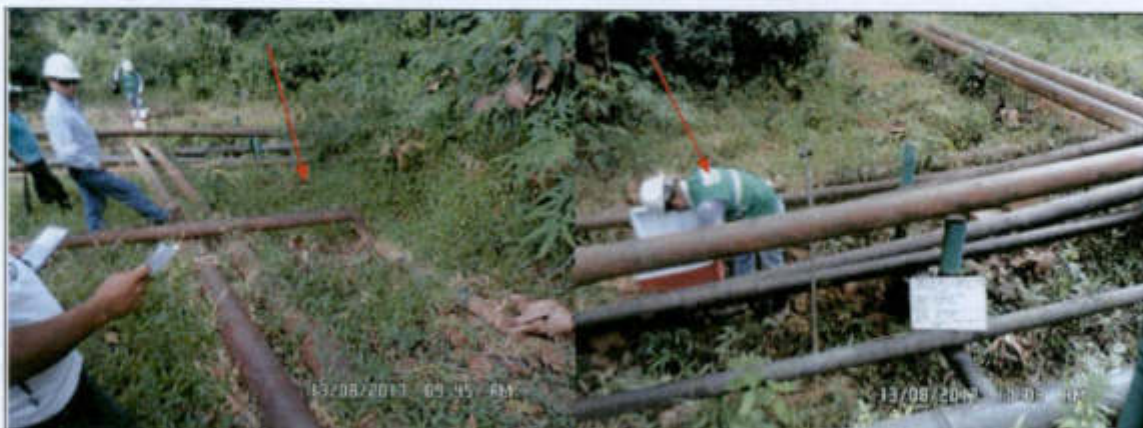
Fotografía: Muestra el joint 81 en funcionamiento, y el área afectada con presencia de vegetación y sin machas de TPH o similares.
