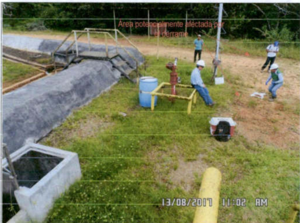
Fotografía N° 4.03: Muestra el Área potencialmente afectada por el derrame. Terreno adyacente al área de contención, es un terreno en la que visualmente no se aprecia restos de hidrocarburos u otro relacionado. (Coordenadas UTM WGS84: 341217 E, 9689961 N).
