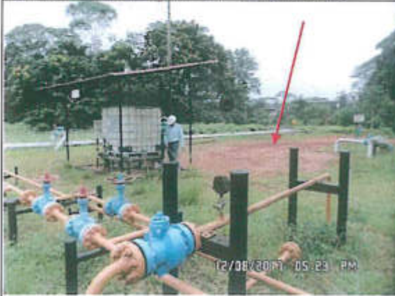
Fotografía: Muestra el área afectada por el derrame en la plataforma de raspatubo.
