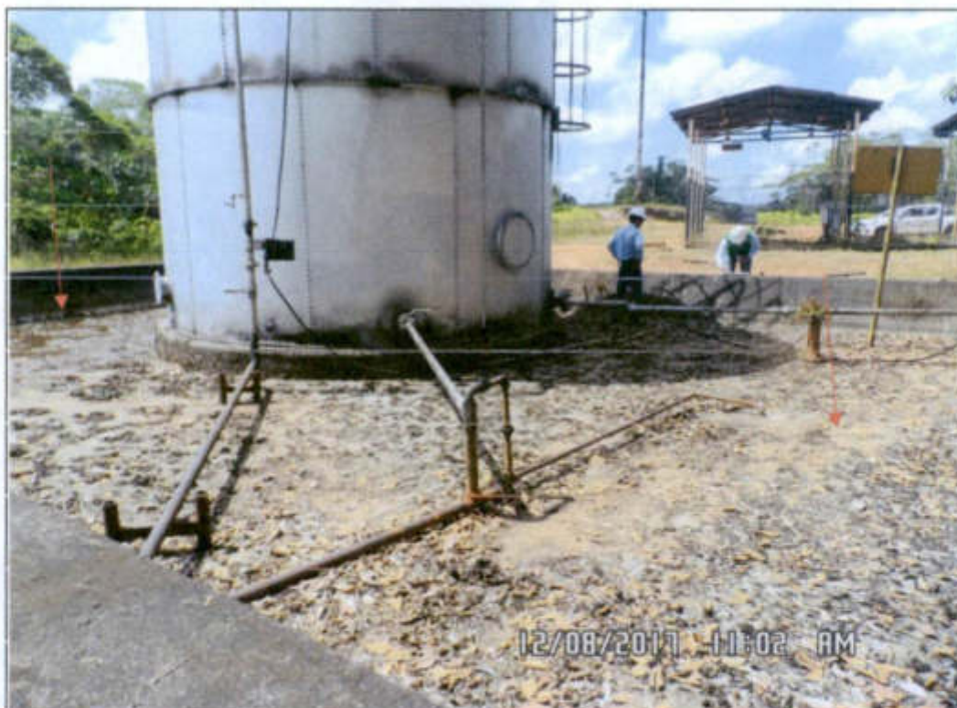
Fotografía N° 2.03: Muestra el área estanca del tanque de diesel, conformado con piso y diques de concreto, con un sumidero y válvula de control y descarga de agua pluvial de 6", punto de vertimiento terreno adyacente en la esquina noreste. Coordenadas UTM WGS84: 332985 E, 9703861 N).
