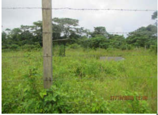
Planta de Tratamiento de Aguas Residuales (PTAR) en el área cercada dentro del
