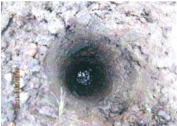
Afectación por hidrocarburos en los hincados realizados durante la visita de reconocimiento
