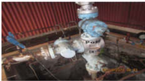
Vista del pozo del campamento Capahuari Sur, ubicado en la plataforma B pozo CAPN-02 S0165
