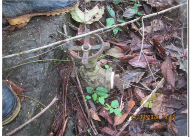
Imagen del desfogue de la tubería que viene del tanque sumidero (Sump Tank), ubicado al lado oeste del sitio
