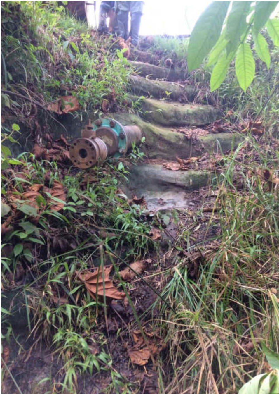
Fotografía 2. Se observa la descarga de residuos de workover, se observa deterioro y oxidación en su entorno presenta suelo con olor a hidrocarburos, vista oeste (W).
