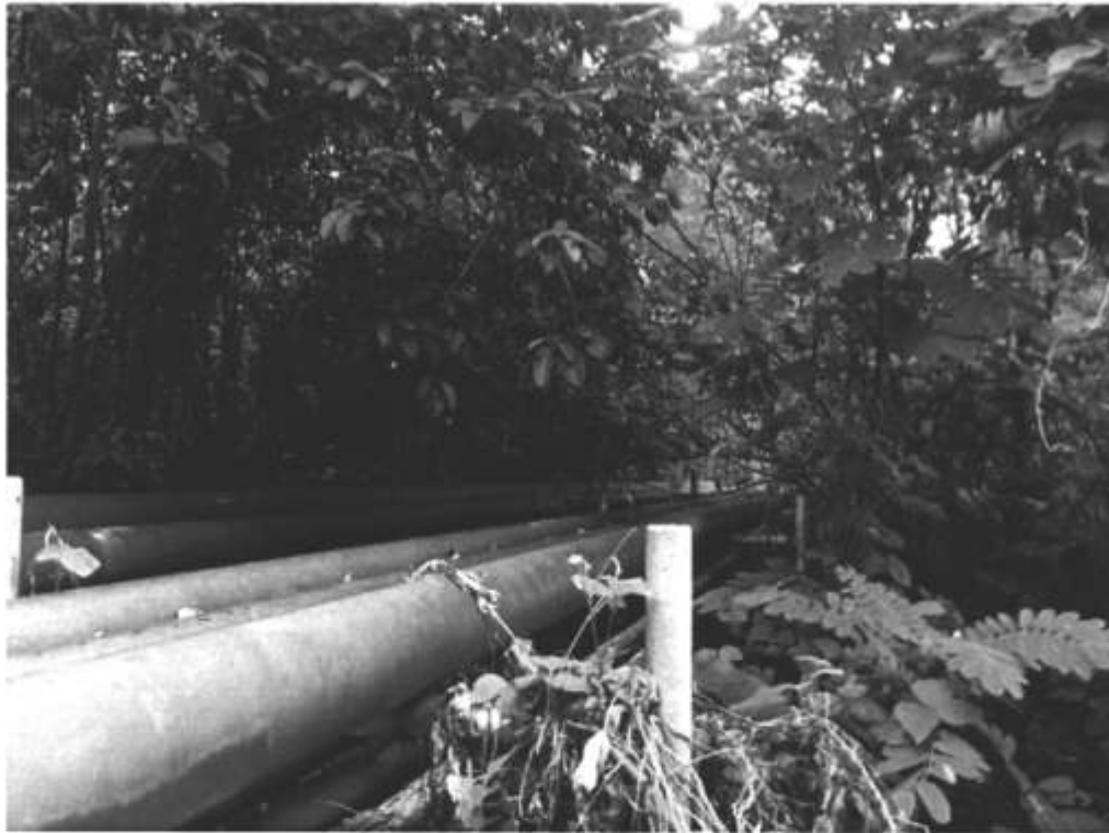
Fotografía 1. Tubería a lo largo del sitio, sin afectación de hidrocarburos.
