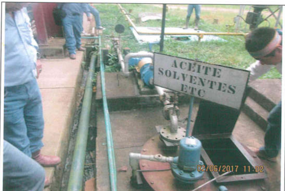
Foto N° 2. Vista de la boca del Sump Tank (tanque subterráneo) ubicado en la Minicentral Eléctrica de Capahuari Sur del Lote 192, donde se generó el derrame de diésel por rebose. Coordenadas UTM (WGS84): 341026 E / 9690046 N.
