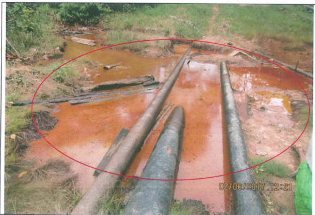
Foto N° 8. Vista de manchas de hidrocarburo ubicado aguas abajo de la quebrada s/n, a la altura del cruce de la línea de 6° de Tambo a Capahuari Sur. Coordenadas UTM (WGS84): 341112 E / 9689992 N.
