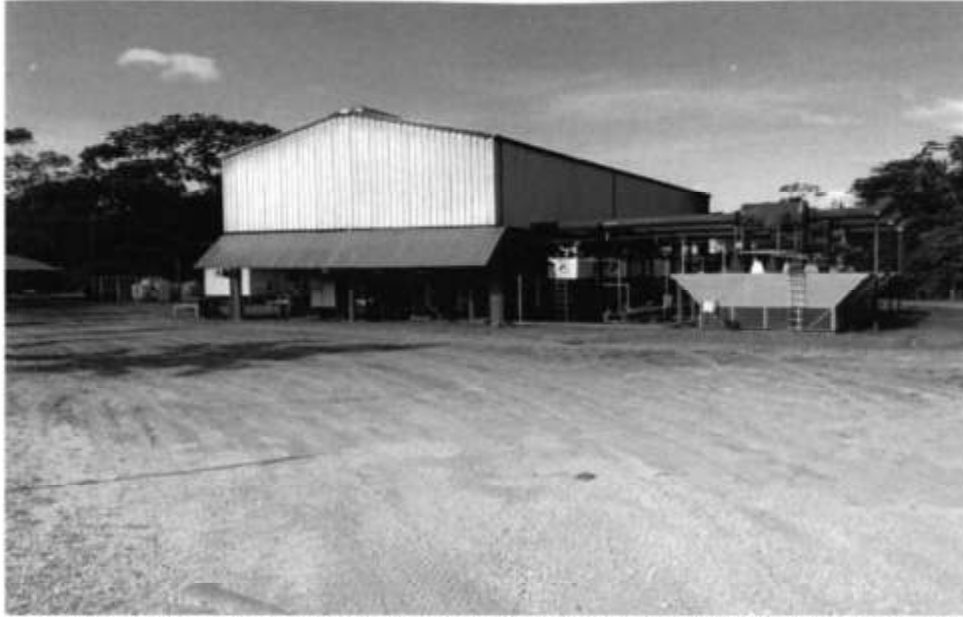
Fotografía 17. Vista de instalación de generación eléctrica Capahuari Sur al noroeste de las afueras del sitio.
