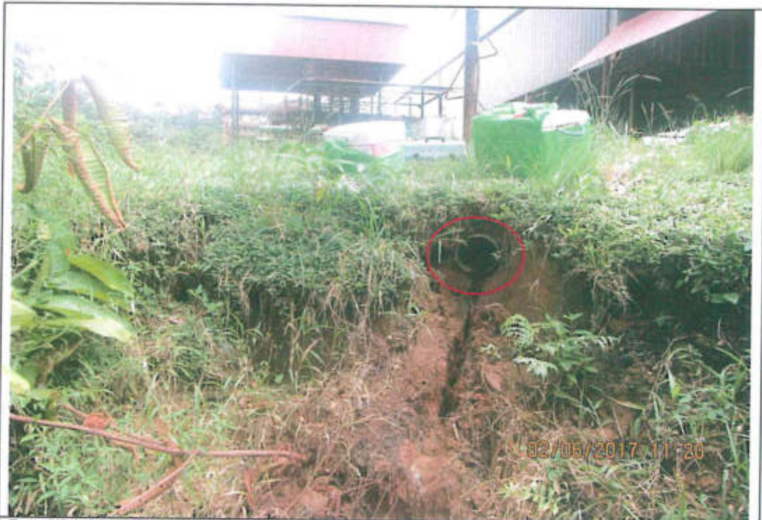
Foto N° 3. Vista de la salida del sistema de drenaje pluvial proveniente de la canaleta de la Minicentral Eléctrica hacia la quebrada s/n. Ubicación donde discurrió el diésel. Coordenadas UTM (WGS84): 341043 E / 9690035 N.
