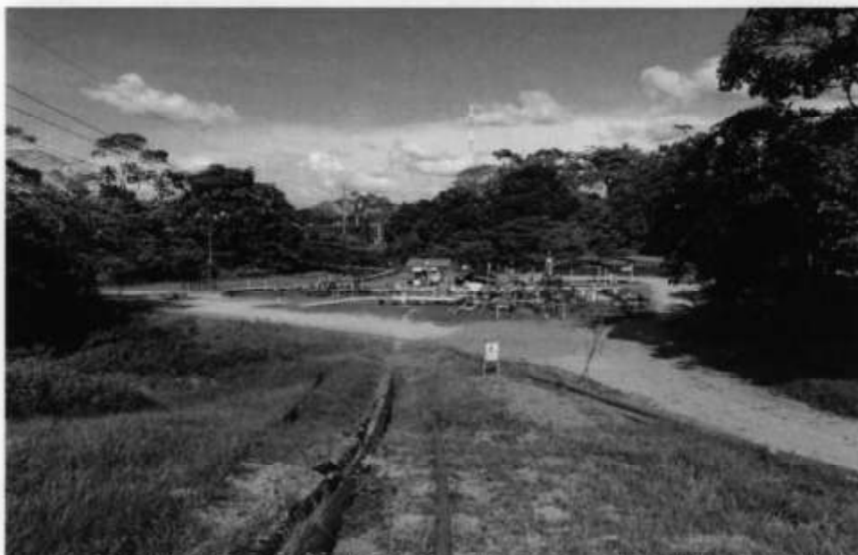
Fotografía 16. Vista de senda de tuberías de producción y chanchería (instalación de limpieza de cañerías) al sur de las afueras del sitio.
