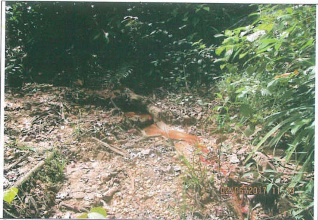
Foto N° 5. Vista de escurrimiento de agua hacia la quebrada s/n, a 15 m aproximadamente de la salida del sistema de descarga de aguas pluviales proveniente de la Minicentral Eléctrica de Capahuari Sur. Coordenadas UTM (WGS84): 341055 E / 9690024 N.
