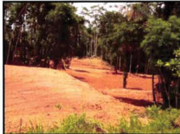
Fotografía 4.- Vista del sitio SJAC 16 remediado, previo a la revegetación.
