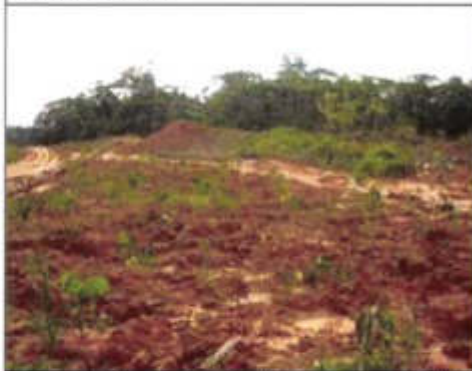
Foto 11: Área remediada, con vegetación instalada en proceso de crecimiento.
