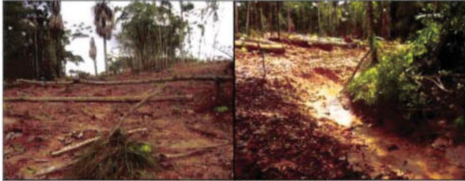
Foto 13: Instalación de medidas para el control de erosión en toda el área remediada, las cuales evitarán que las aguas pluviales laven el suelo permitiendo el buen desarrollo de los plantones instalados.
