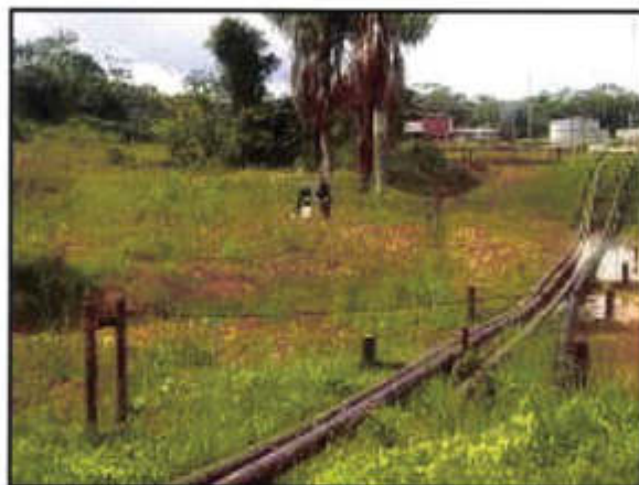
Fotografía 6.- Vista general del área remediada, se aprecia el área casi completamente cubierta de vegetación de crecimiento natural y plantones instalados.
