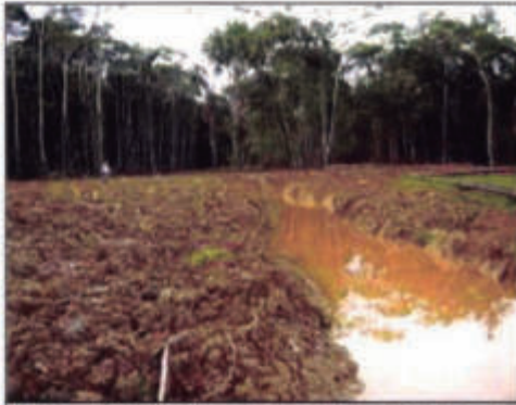
Foto 13: Canal principal de drenaje de aguas de lluvia, la coloración del agua es debido a la turbidez natural de las aguas.
