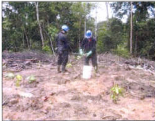
Foto 07: Personal de GyM realizando las calicatas necesarias para la obtención de la muestra M-01.
