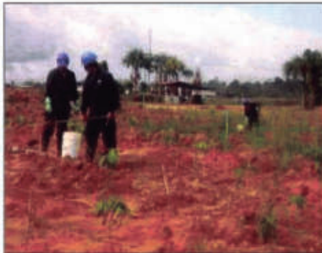
Foto 07: Realizando calicatas para la muestra M-01 en otra sector del área remediada.
