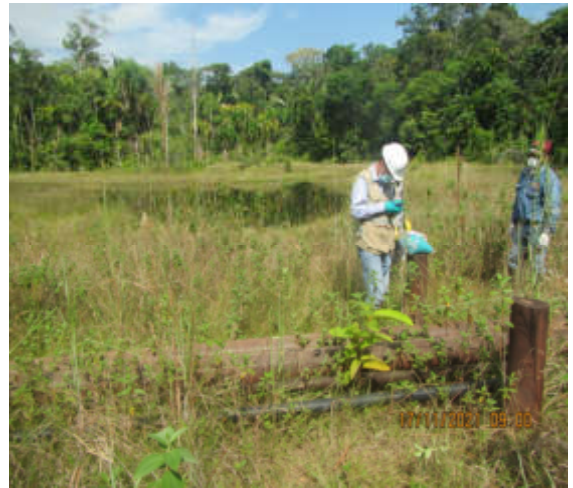
Oleoducto que transporta hidrocarburos de la Plataforma C hasta la Batería San Jacinto, y atraviesa el sitio S0463
