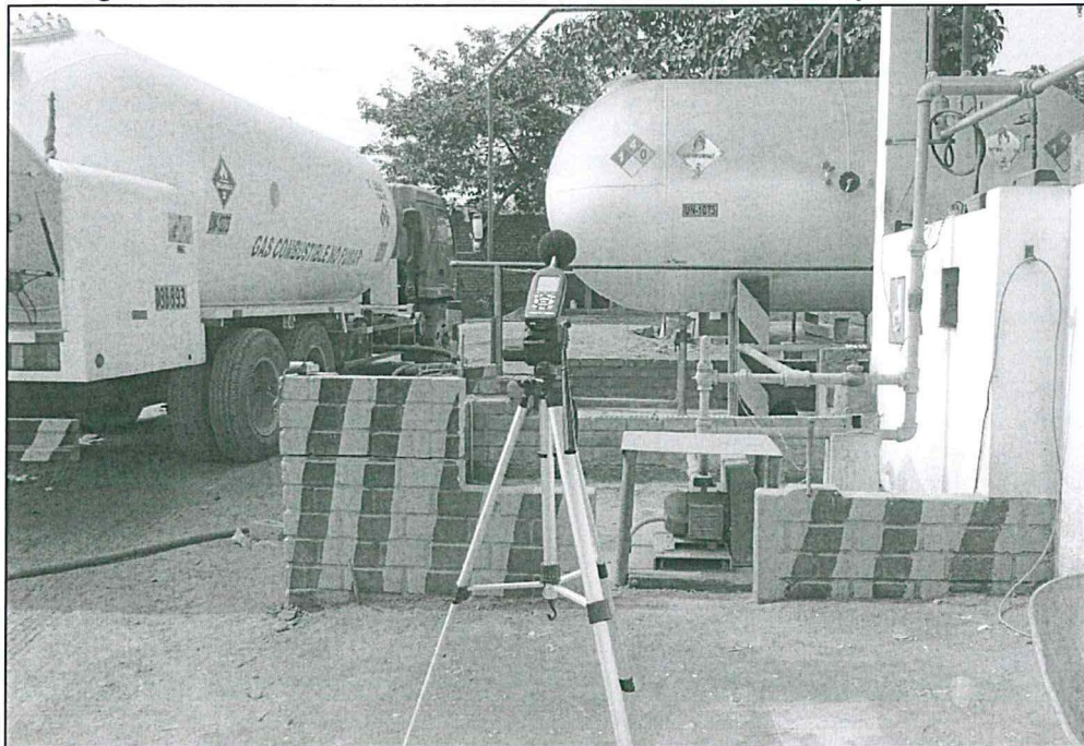
Fotografía N° 01: RA-EDRAN-01, zona de la bomba de GLP para envasado.
