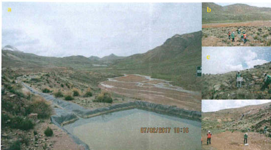
Figura 9-14. Área de potencial interés – API CSA-9, observaciones identificadas in situ . a) Imagen panorámica del área de potencial interés (CSA-9) ubicada en la margen derecha del río Chacapalca y parte baja del botadero N° 1, b) Imagen panorámica del punto CSA-9d, c) Imagen panorámica del punto CSA-9f, y d) Imagen panorámica del punto CSA-9f.
