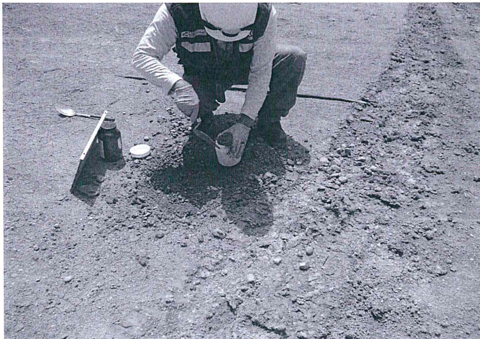
Fotografía N° 4 Punto de muestreo de suelo mediante calicata de 0,30 metros de Profundidad.
