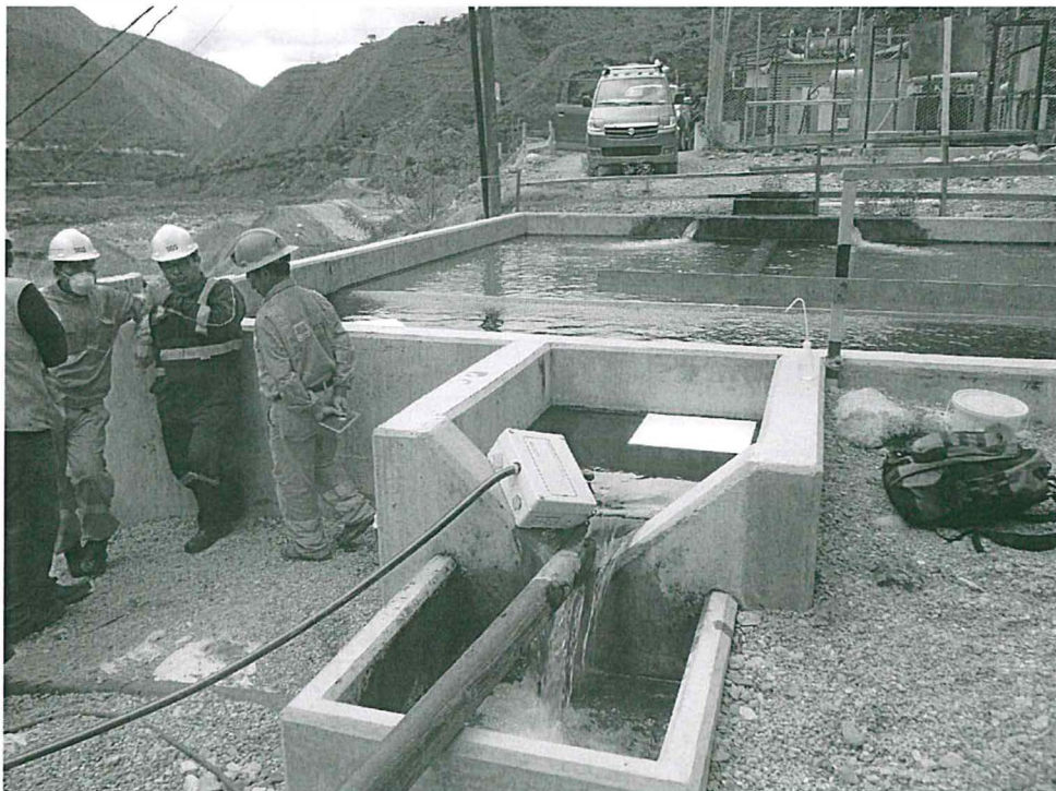
Fotografía N° 5: Punto de Monitoreo de Efluente EF-01.
