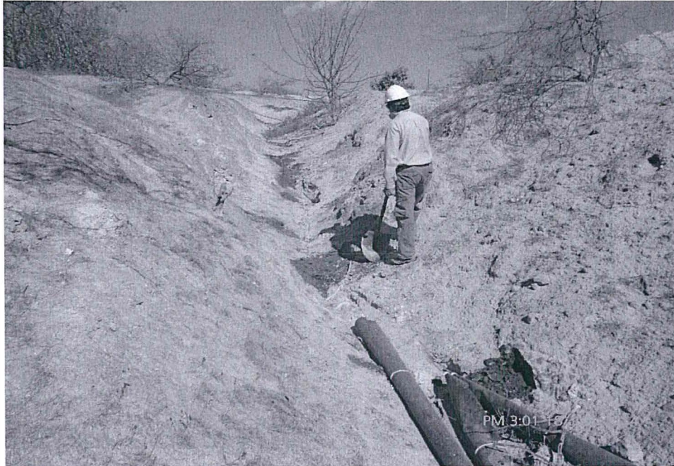
Fotografía N° 3 Suelo impregnado con hidrocarburo a 98 metros de distancia de los tanques de almacenamiento de la Batería 325.
