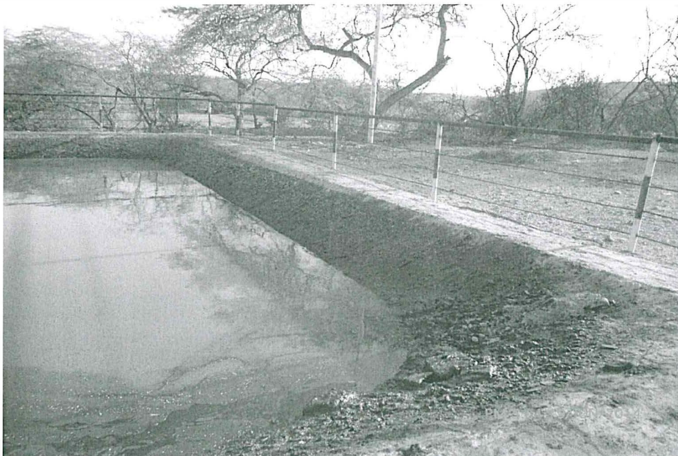
Fotografía N° 10. Poza de evaporación donde se observa el agua con láminas de hidrocarburos.
