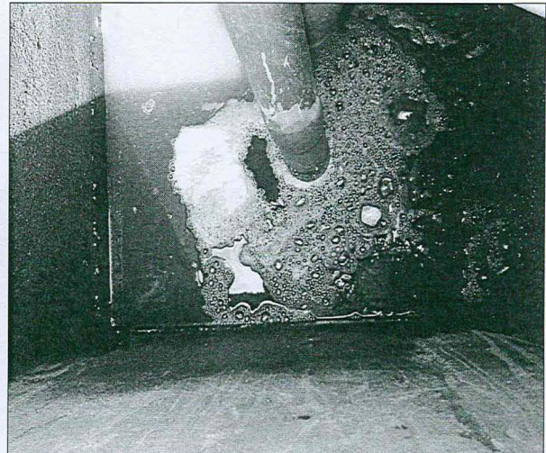
Fotografía N° 10. Buzón final, donde se observa espuma sobrenadante de color naranja, por el pigmento característico de los langostinos materia prima del proceso de congelado.
