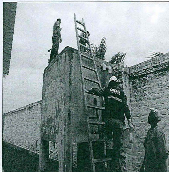
Fotografía N°12. Subiendo para la recolección del efluente a la entrada del tanque de almacenamiento.
