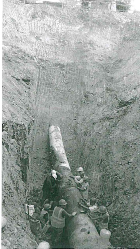
Fotografía N° 5. Personal de Petroperú retirando el material de cobertura de Oleoducto Norperuano, a la altura del KM 547+463.
