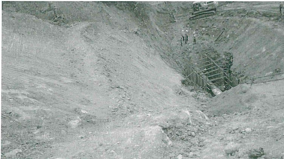
Fotografía N° 6. Personal de Petroperú construyendo una jaula para proteger al personal de la caída de piedras en el Oleoducto Norperuano, a la altura del KM 547+463.
