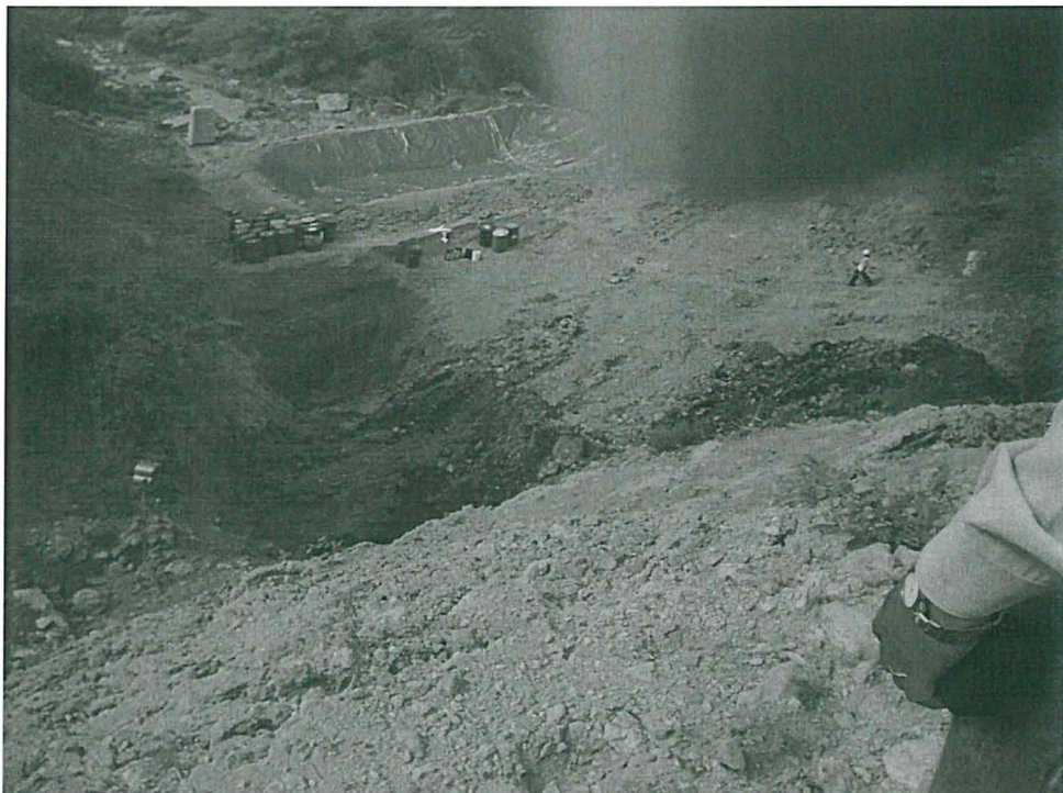
Fotografía N° 8. Área afectada por el derrame de hidrocarburos en el área de influencia del KM 547+463 del Oleoducto Norperuano
