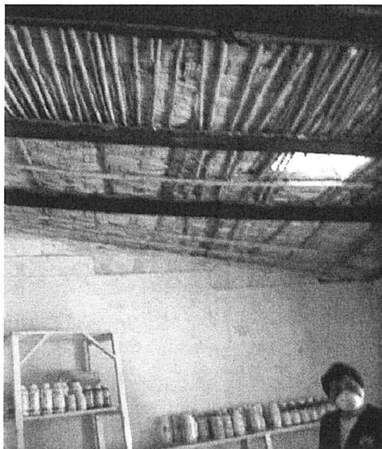
Fig. N° 9. Techo del almacén con ventana inapropiada, riesgo de incendio por efecto de sustancias químicas y productos sin seguridad.
