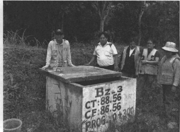
Foto 3a: Buzó N° a, a partir del cual el effluente de la Refinería Iquitos cambia de dirección de descarga al río Amazonas. (Actual)
