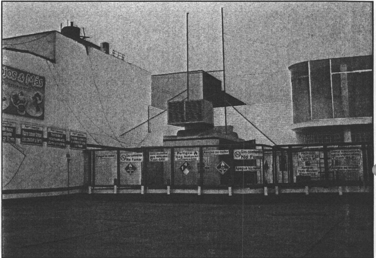
FOTOGRAFIA 05, Estación de Servicio Monte Everest - Grifo Petroamérica
