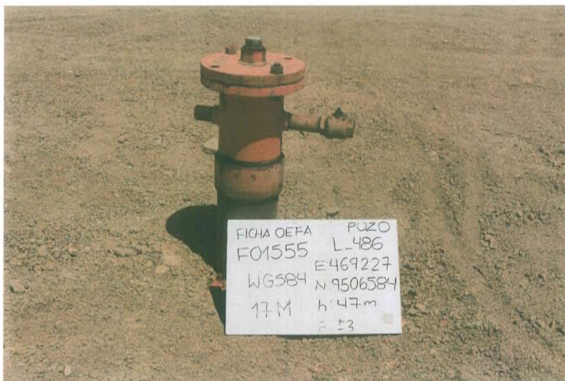
Fotografía N° 1. Identificación del pozo inactivo con código PERUPETRO L_486. Presenta casing con brida y tubo lateral sin válvulas que aseguren su hermetismo.
