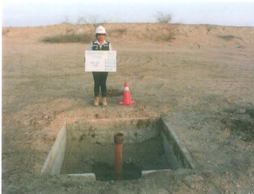
Fotografía N° 1. Vista del pozo T5477 ubicado en una planicie adyacente a la vía de acceso.
