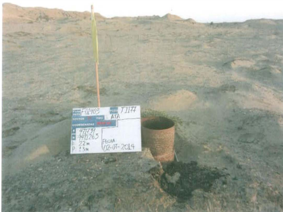
Fotografía N° 1. El Pozo T1177 no presenta cabezal ni válvulas que aseguren su hermetismo por lo que se considera que esta abierto y expuesto al ambiente.
