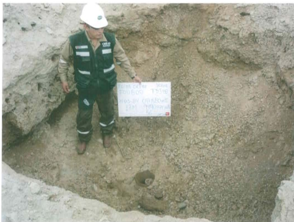
Fotografía N° 1. Pozo inactivo con código de PERUPETRO T5348 se observa casing de 9 pulgadas de diámetro a nivel del suelo, dentro de hoyo de 1,1 m de profundidad.
