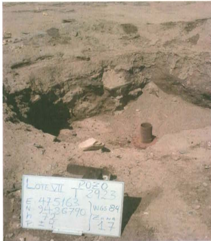
Fotografía N° 1. Se ubicó al pozo en una excavación de sección rectangular, presenta brida con tubería de reducción abierta sin elementos de cierre que garanticen su hermetismo.
