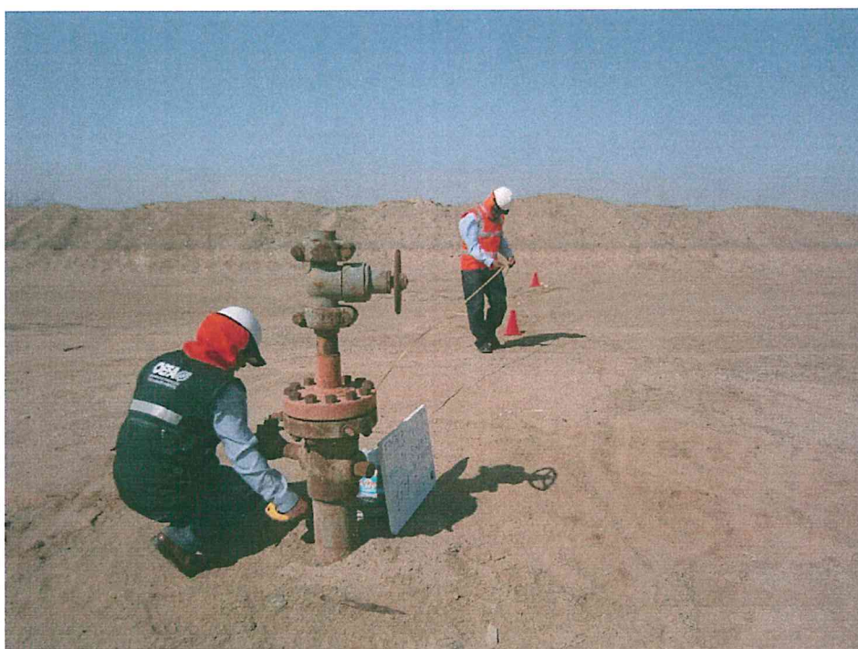
Fotografía N° 2. El pozo emerge 1,3 m del nivel del suelo cuenta con brida y válvulas abiertas que exponen el interior del pozo al ambiente.
