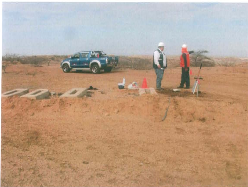
Fotografía N° 2. Vista panorámica del área evaluada del Pozo L_1821, donde se observa las vigas monolíticas que fueron las bases de la estación de la unidad de bombeo.
