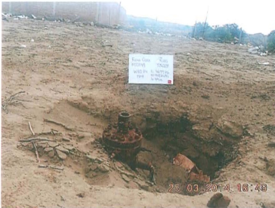
Fotografía N° 1. Se observa el cabezal del pozo T5028 en el interior de un hoyo cubierto de arena en un terreno de propiedad privada.
