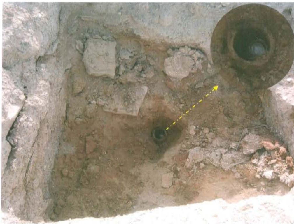
Fotografía N° 3. En el interior del casing se observó otra tubería de menor diámetro con presencia de fluidos en su interior.
