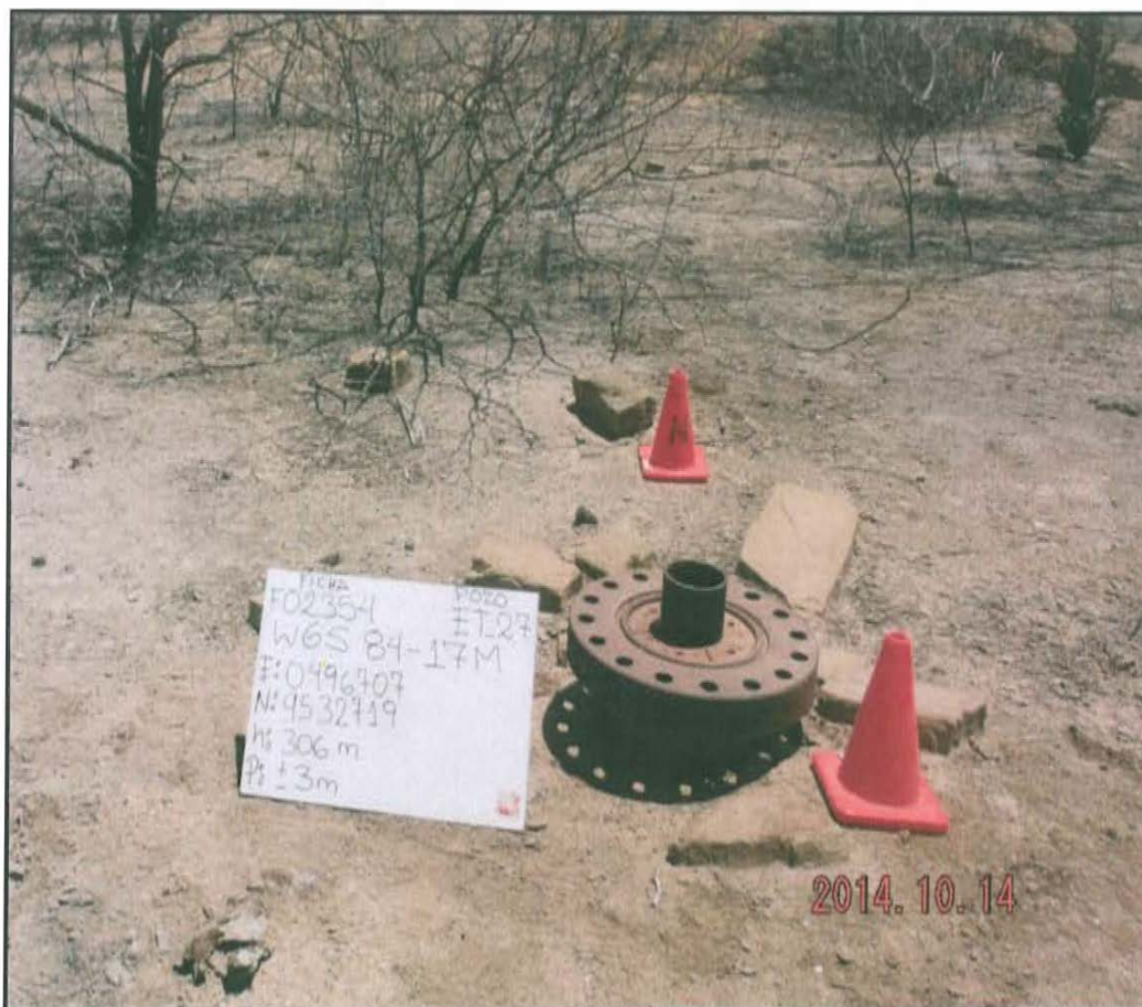
Fotografía N° 1. Pozo ET_27 presenta cabezal de pozo que emerge a una altura de 0,3 m desde la superficie del suelo.
