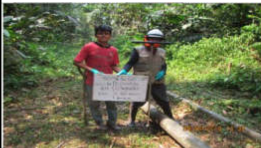
Vista de un grupo de oleoductos que atraviezan el área del sitio S0176
