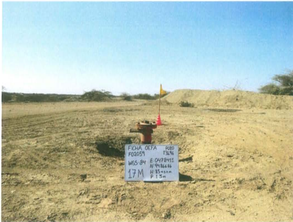
Fotografía N° 1. Pozo inactivo con código PERUPETRO T3696 donde se observa casing con brida a una altura aproximada de 0,8 m sobre el fondo de un hoyo.
