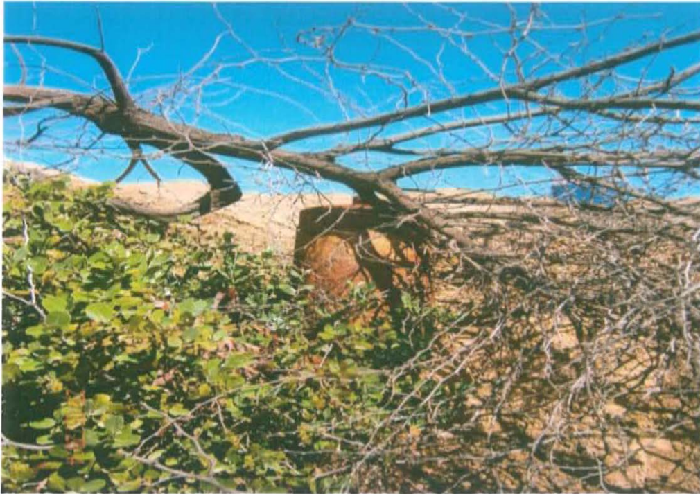
Fotografía N° 1. Vista de ubicación del pozo donde se observa el pozo con el casing y brida en estado de deterioro y abierto.
