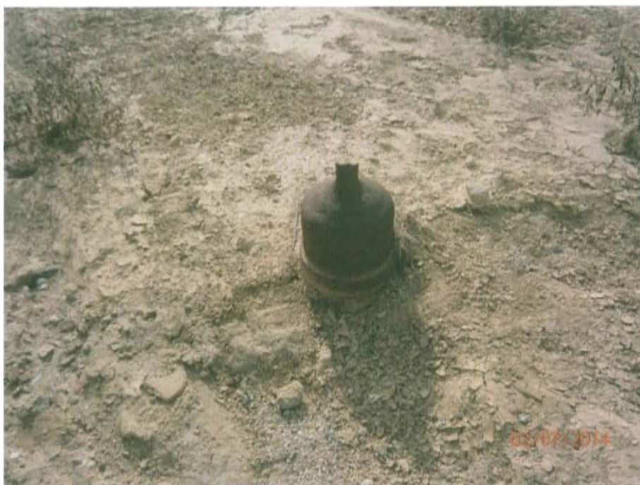
Fotografía N° 1. Vista de la ubicación del pozo donde se observa el Tubo de revestimiento sin cabezal con signos de corrosión y expuesto al ambiente.
