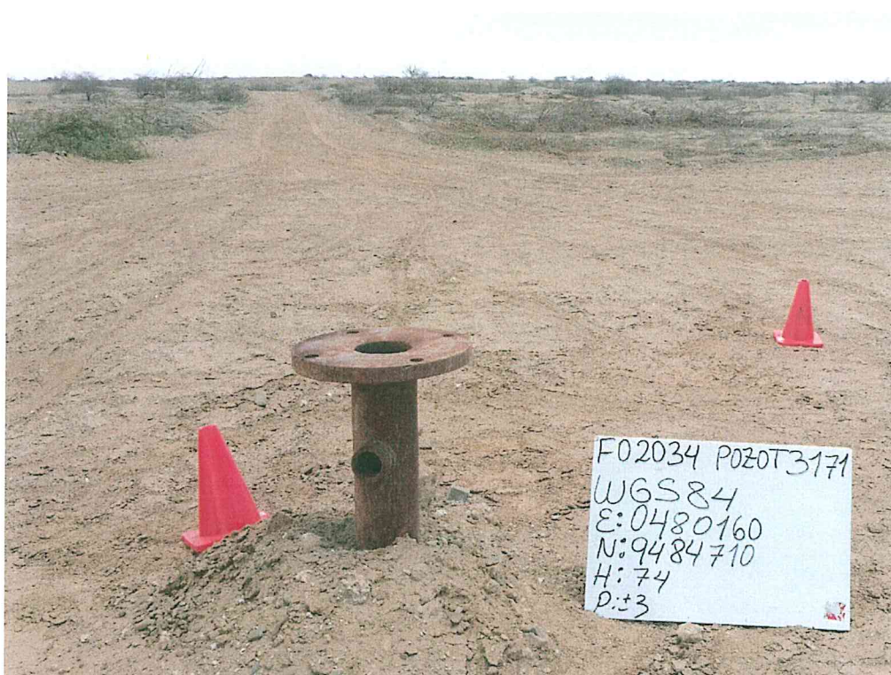
Fotografía N° 1. Pozo T3171 con casing en estado de corrosión, de 0,4 m de altura sobre el nivel del suelo sin accesorios que aseguren su hermetismo por lo que se le consideró como un pozo abierto y expuesto al ambiente.
